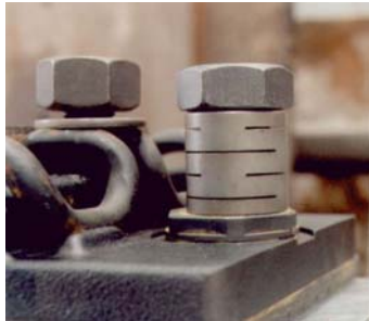
Schienenbefestigung mit Linearfeder LIF / Da = 40 mm
