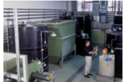
Vollautomatisch und doppelt überwacht: unsere moderne Emulsionspaltanlage
