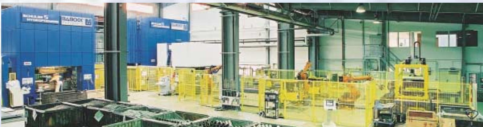
Komplett automatisierte Hydroformanlage 5.000 t und manuell bedienbare Hydroformanlage 3.500 t Fully automatic hydroforming plant 5,000 tons and manually operable hydroforming plant 3,500 tons
