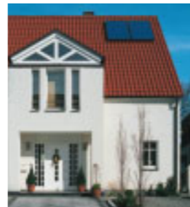
Einfamilienhaus mit zwei Kollektoren aus der Kompakt-Linie
