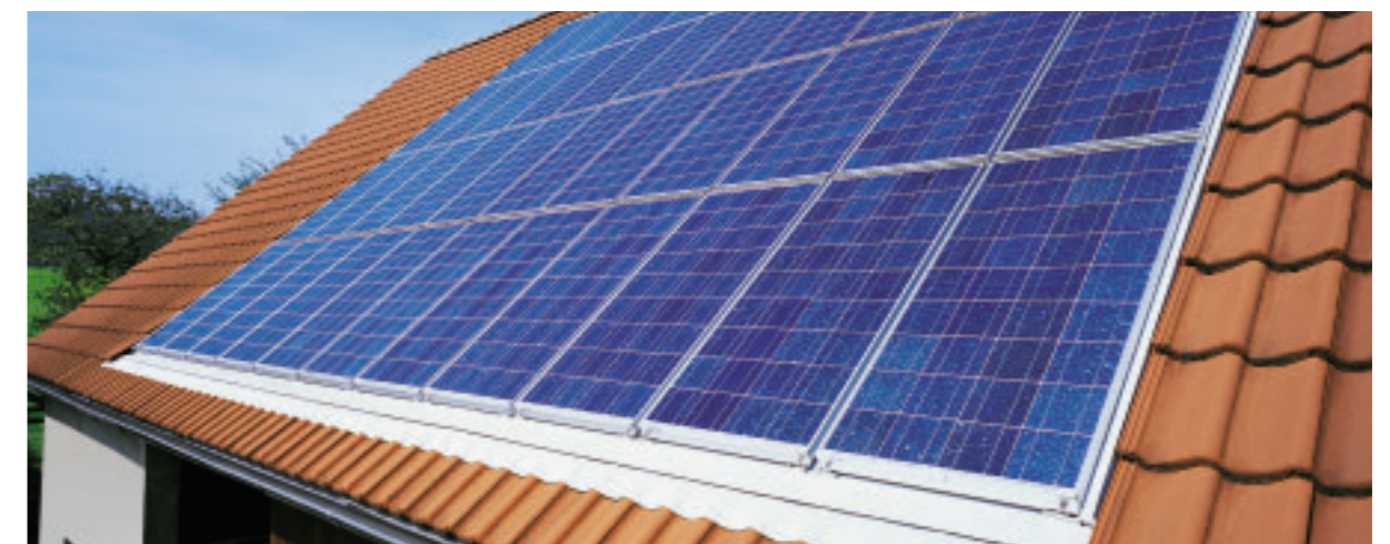
Scheunendach mit PV-Light Indachmontage
