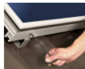
Kollektor bündig verschrauben
