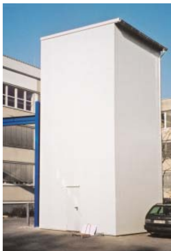
TBL I einzeiliger Blechlagerturm für Großformatbleche mit 23 Paletten a 3 to sowie einem Entpalettierwagen
